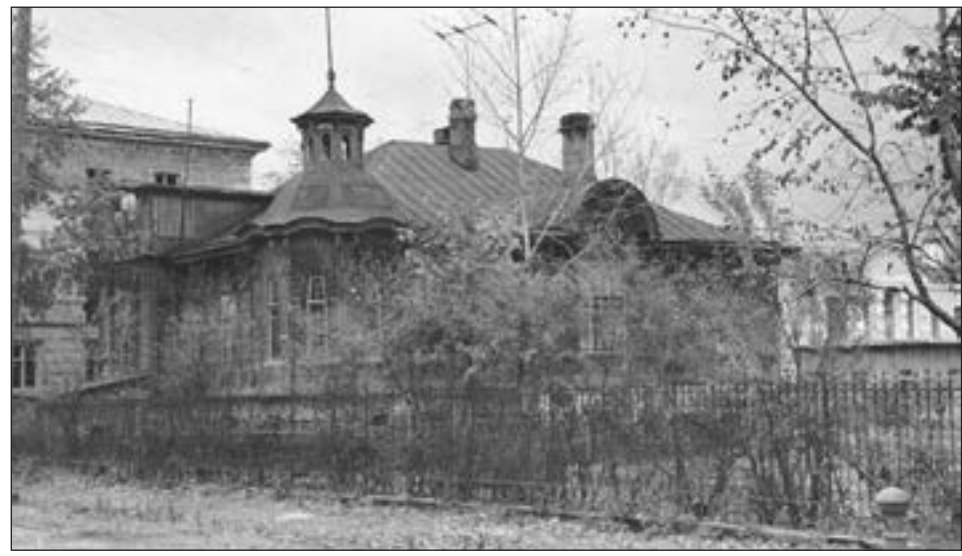
ул. Урицкого 17-19. 1960-70 гг. Источник: ok.ru/gatchinapolnesnoe
